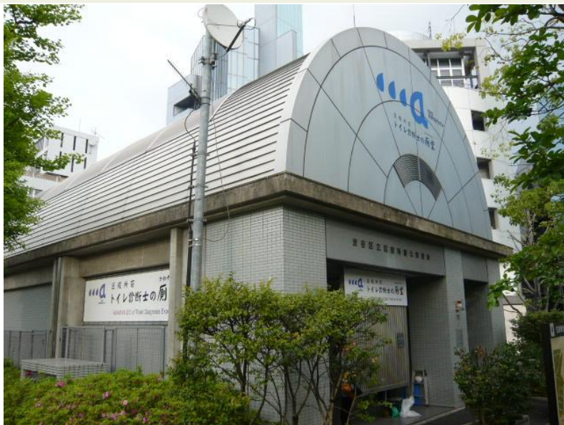
渋谷区公衆トイレのネーミングライツでは『トイレ診断士の殿堂』と命名
