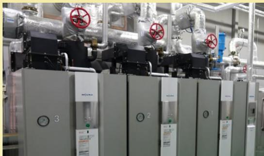
主力製品の小型貫流ボイラ。複数のボイラを設置し、必要なときに必要な分だけ動かせるのが特徴。
