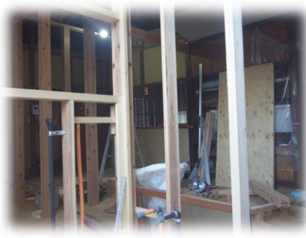
台所も改装工事を行っています
